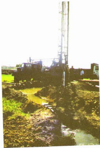
Savak ile su veriminin ölçülmesi
