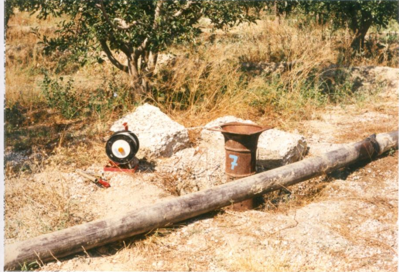
Foto 6.2b. S-7 nolu kuyuda pompa testi esnasında su seviye ölçümü yapılmaktadır
