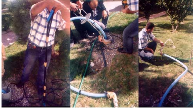
Elektrotlar -Pompanın kuyu içine indirilmesi ve çalışması
