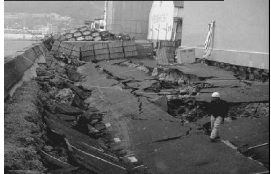
1995 Kobe depreminde sıvılaşma sonucu oluşan istinat duvarı yenilmesi (liman)
