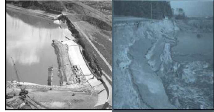
1971 depreminde Lover san Fernonda barajında oluşan akma göçmesi
